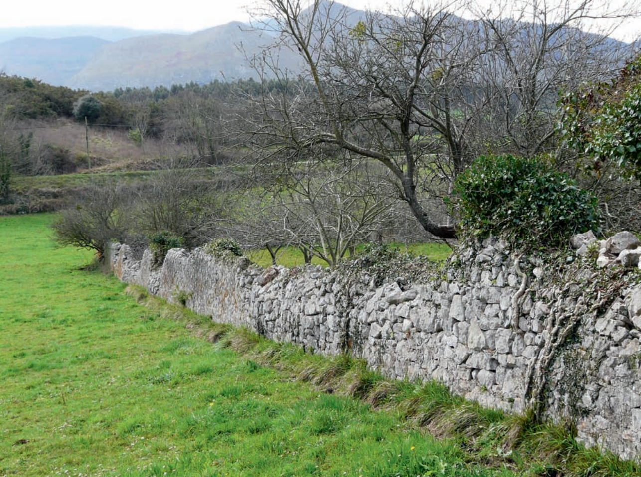
Cierres de piedra seca, residuos de antiguas formas de organización del terrazgo
